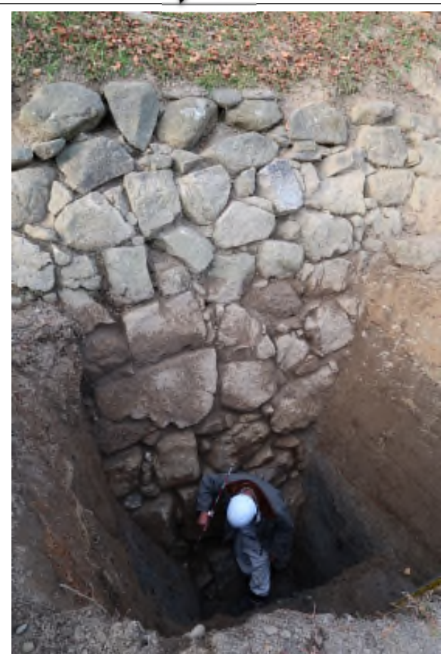
写真1 石垣埋没部の確認 (石垣総高 4.5m まで確認)
