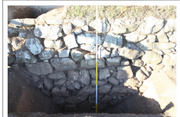
写真2 石垣埋没部の確認 (刻印が残る石材も確認)。
