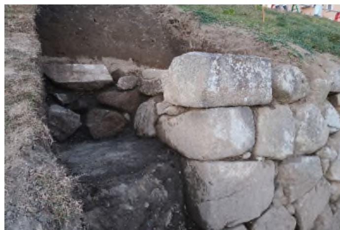
写真4 隅部の折れ(正面から)
