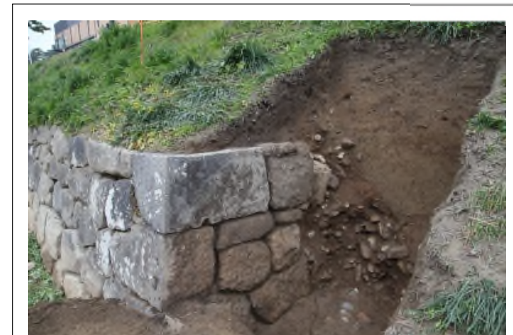
写真3 隅部の折れの確認 (一部崩落により裏込め石が流出)
