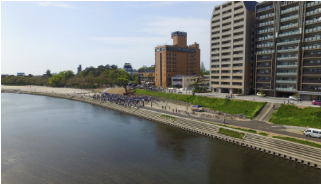
菅生川端石垣 遠景
