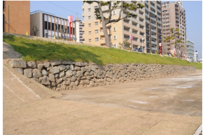
菅生川端石垣 近景
