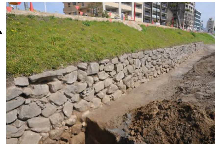
写真 1 地点⑥石垣検出状況（調査後）
